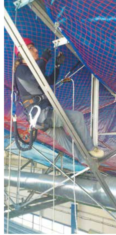
FABRİKA ÇATI DEĞİŞİMİ PERSONEL GÜVENLİK AĞI UYGULAMASI
