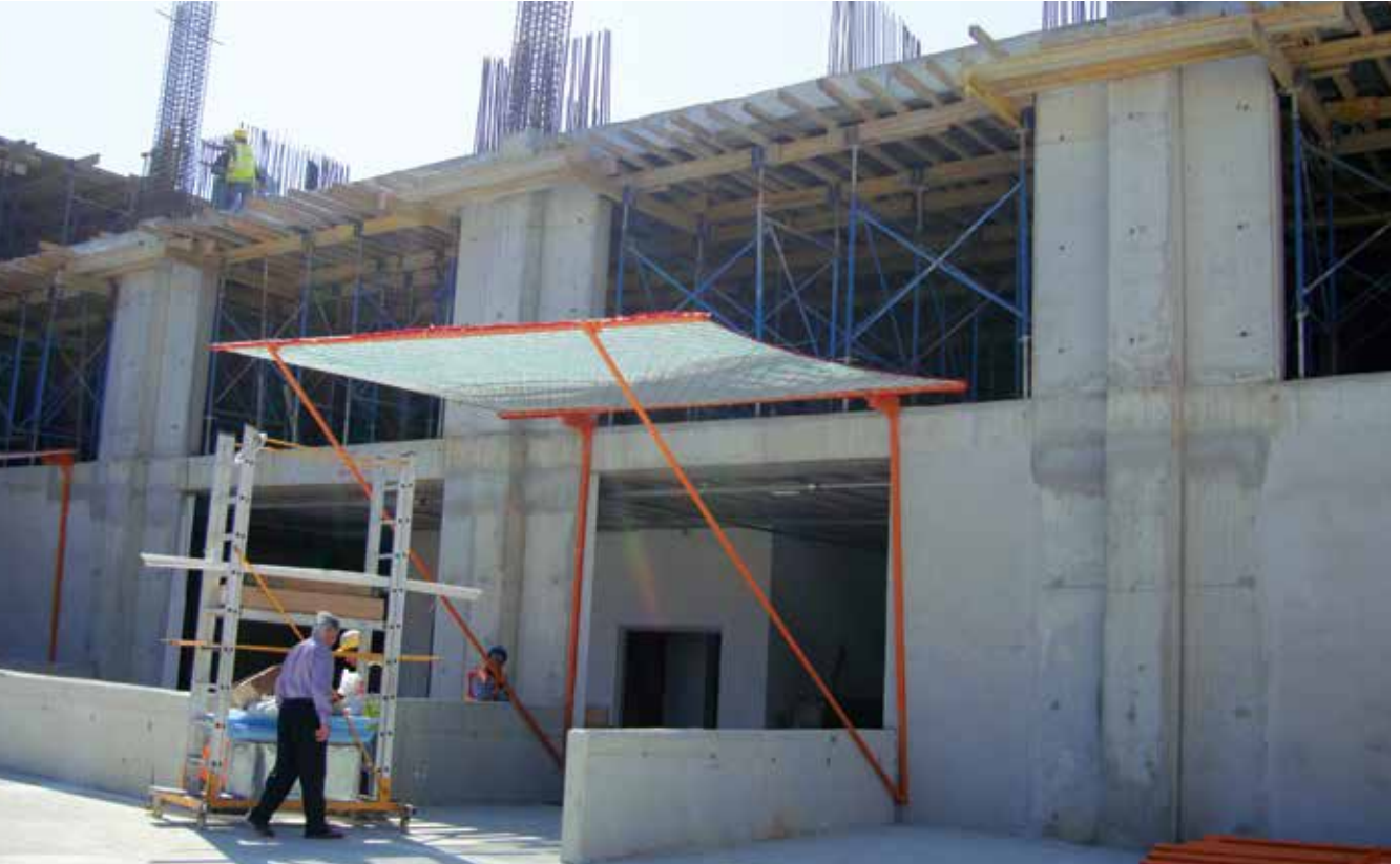
İNŞAAT GİRİŞİ İÇİN P. GÜVENLİK AĞI PLATFORMU UYGULAMASI
