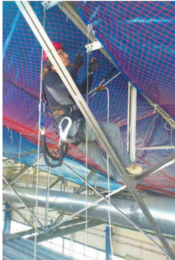
FABRİKA ÇATI DEĞİŞİMİ PERSONEL GÜVENLİK AĞI UYGULAMASI
