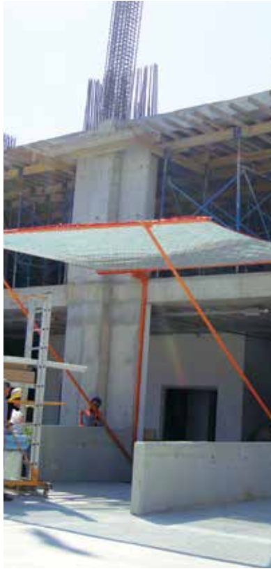
İNŞAAT GİRİŞİ İÇİN PERSONEL GÜVENLİK AĞI PLATFORMU UYGULAMASI
